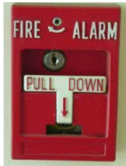
ภาพที่ 5 สัญญาณเตือนภัยแบบต่างๆ ได้แก่ Fire Alarm และ Smoke Detector ตามลำดับ
