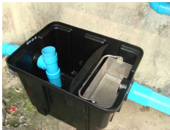
ภาพที่ 24 รูปแบบทั่วไปของบ่อดักไขมันสำเร็จรูป
